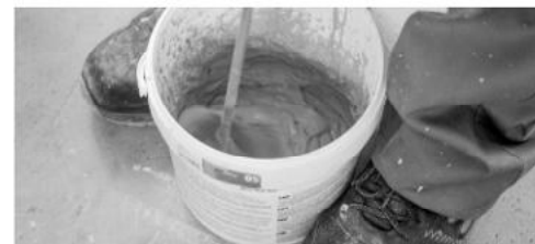
Prepare the grout | Prepara el material de rejuntado | Préparer le matériau de jointolement | Rühren Sie das Fugenmaterial an
