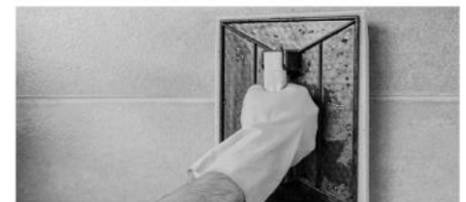
Remove any leftover grout and other dirt | Elimina los residuos de junta y demás suciedad | Éliminer les résidus de jointolement et autres saletés | Entfernen Sie Fugenmaterialreste und andere Verunreinigungen
