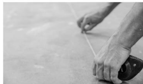
Set the guideline | Plantea la línea maestra | Établir la ligne magistrale | Spannen sie die richtschnur
