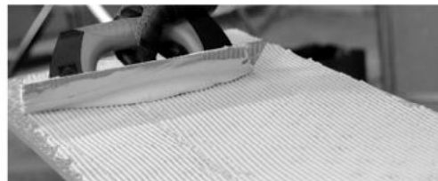
Make sure the thickness of the layer of adhesive cement is uniform | Asegúrate de que el grosor de la capa de cola sea uniforme | Veiller à ce que l'épaisseur de la couche de ciment colle soit uniforme | Vergewissern Sie sich, dass die Kleberschicht gleichmäßig ist
