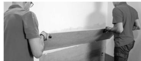
Affix the tile to the pre-prepared surface | Colocala la pieza sobre la superficie preparada | Placer la pièce sur la surface préparée | Verlegen Sie die Fliese auf der vorbereiteten Oberfläche
